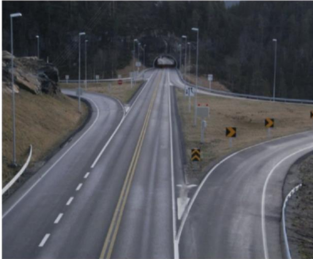
Nye Veier jobber med planer om ny firefelts vei over Kvinesheia. Et sentralt spørsmål er hva som skal skje med den gamle veien. FOTO: TORBJØRN WITZØE
